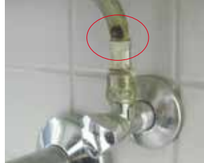
Flexschlauch ist verrostet – ein Wasserschaden wird möglich.
