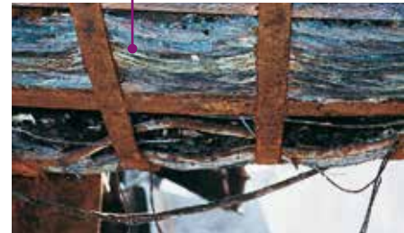
Erhebliche Brandlast durch Elektroinstallation.
